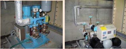
給水設備更新工事
